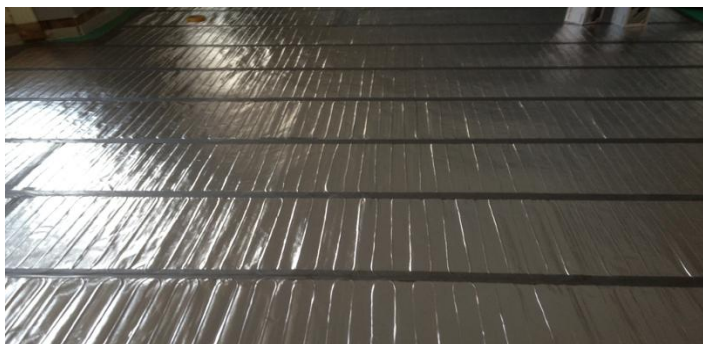
10. ábra. Az AluMat fűtőszőnyegek a telepítés befejezése után
